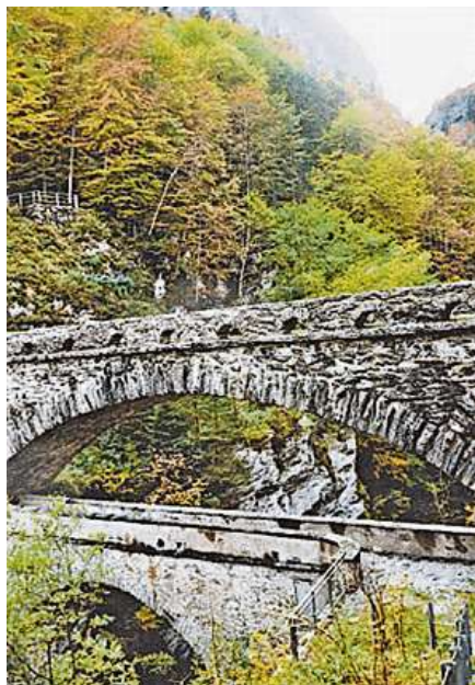
Die Pantenbrücke im Tierfehd.
