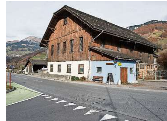
Der Viehstall wird umgenutzt , der Schweinestall weicht einem Neubau. (FOTO OLIVIA ITEM)
