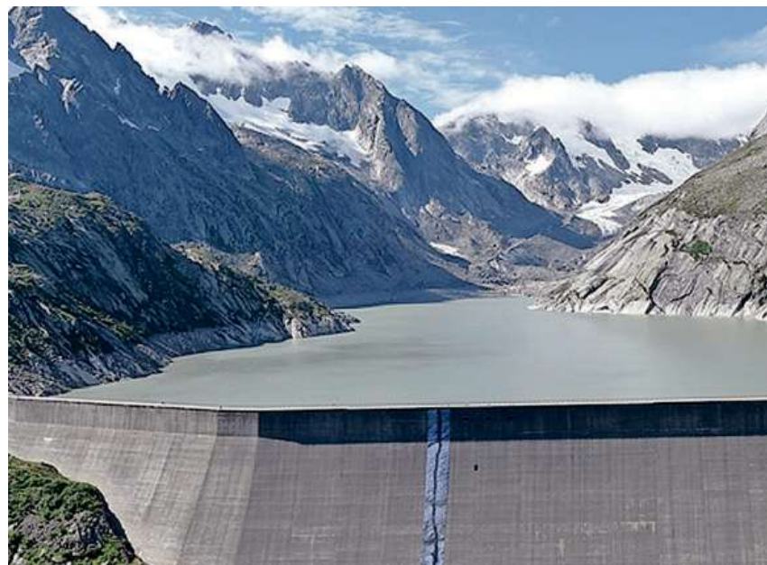
Jetzt in Buchform: Riss, den Maya Lalive in der Albigna-Staumauer installierte.
